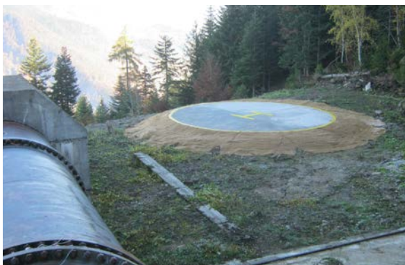
DZ spécialement aménagée en prévision d'un chantier de longue durée comportant de l'héliportage.
