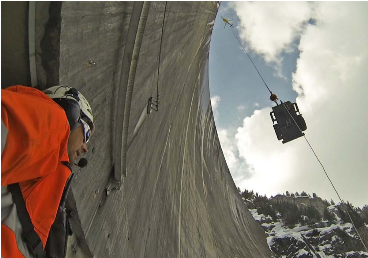
Une charge en approche avec sa corde de guidage, une bonne pratique.
