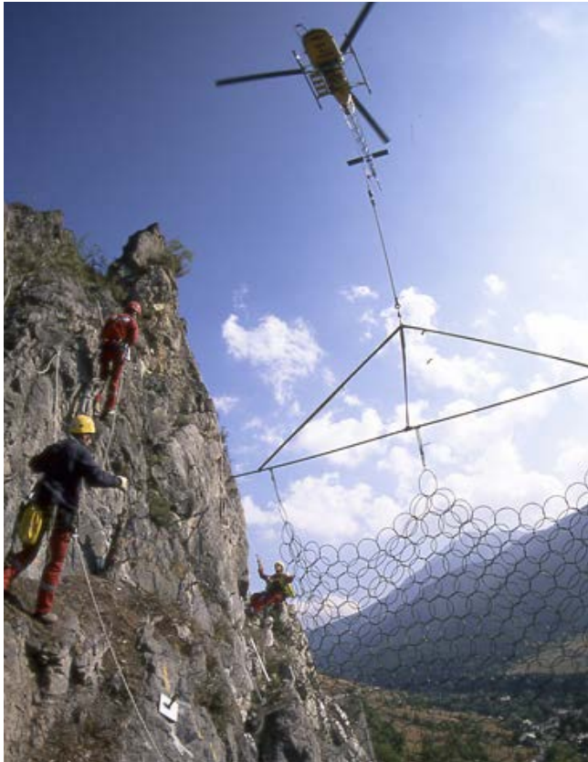
Héliportage d'un filet de protection contre la chute de bloc en pleine falaise, un travail de spécialiste qui nécessite une parfaite coordination pilote/équipe au sol.
